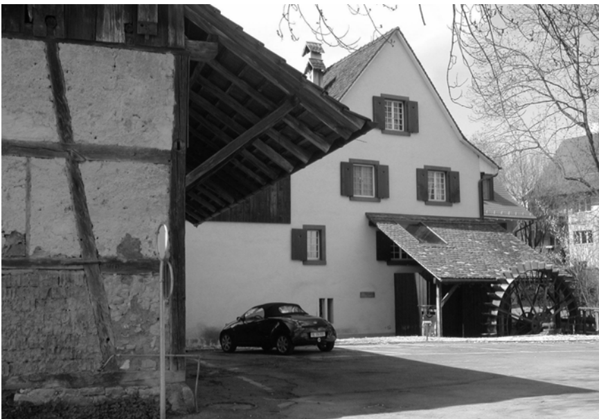
Ansicht Gipsmühle und Scheune
