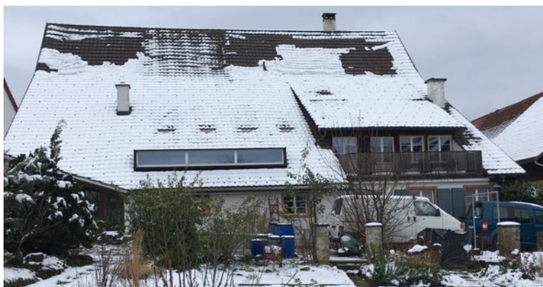
Abbildung 6: Beispiel Hauptstrasse 6, Rüenberg; Fläche Dachaufbauten Faktor 1.15 zu Fassadenbreite
