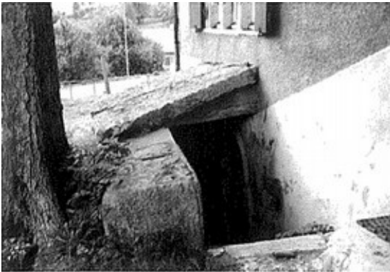
Abbildung 7: Schachtartiger Kellerabgang. Die Bauernhäuser der Kantone Basel-Landschaft und Basel-Stadt.
