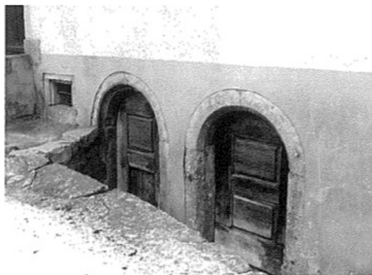
Abbildung 8: Schachtartiger Kellerabgang. Die Bauernhäuser der Kantone Basel-Landschaft und Basel-Stadt.
